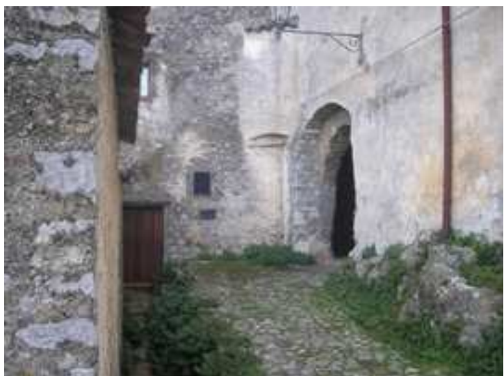
Interno della porta di accesso al Castello
